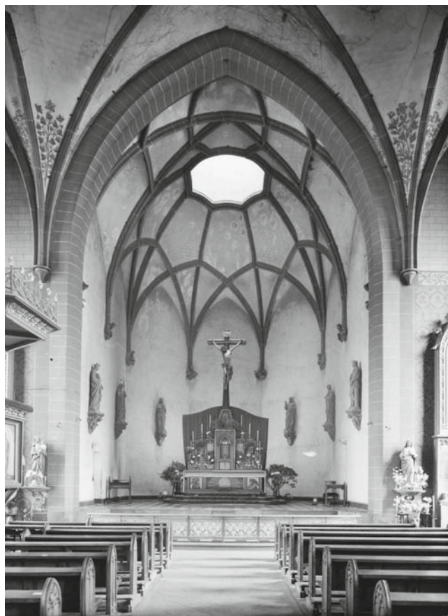
Abb. 2 Innenansicht des Chores (Aufnahme 1954)
