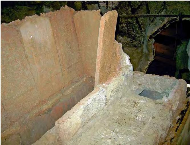
Abb. 13 Wärmeluftöffnung mit Biberschwanzdachziegel gemauert, rechts eine Umbrandöffnung vom 4. in den 5. Zug
