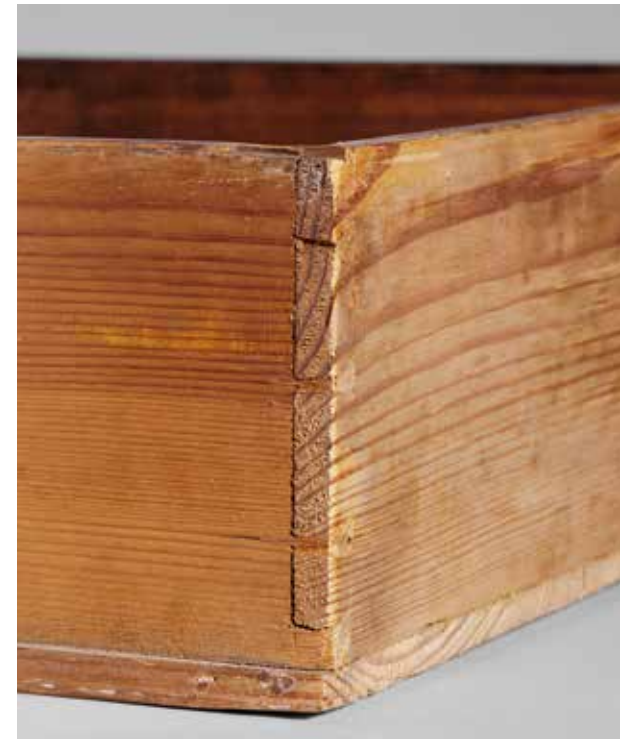
60f Zinkung am Hinterstück der 3. Schublade
