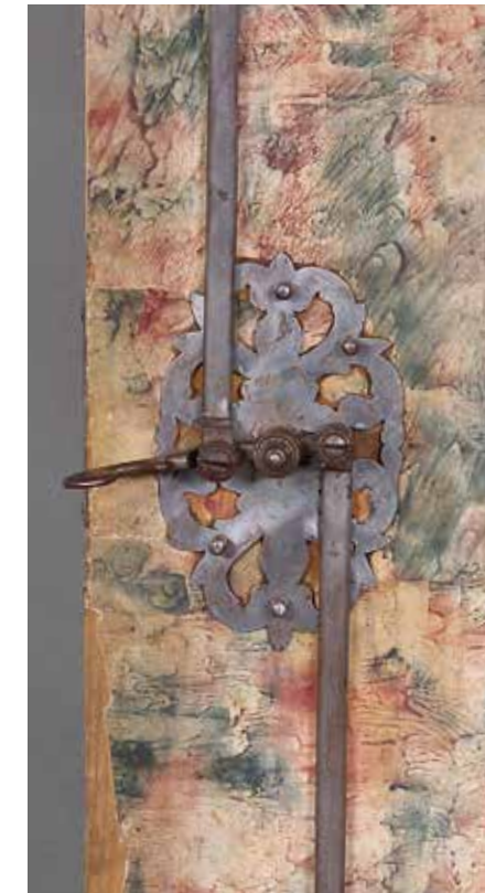
212 Triebstangenriegel in der linken Tür von Kat. 44
