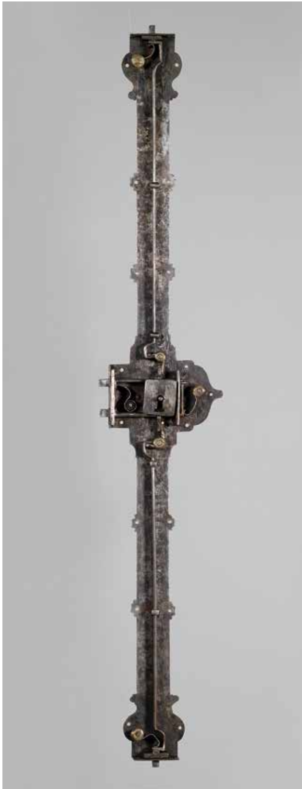
209 Rückseite des ausgebauten Triebstangenschlosses von Kat. 48
