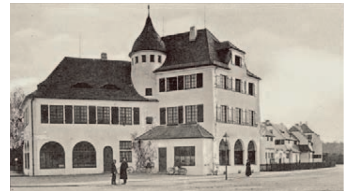
Abb. 64 Gartenstadt Nürnberg, Postkarte mit dem ehemaligen Verwaltungsgebäude. Aufnahme um 1912 (Kat. 68)
