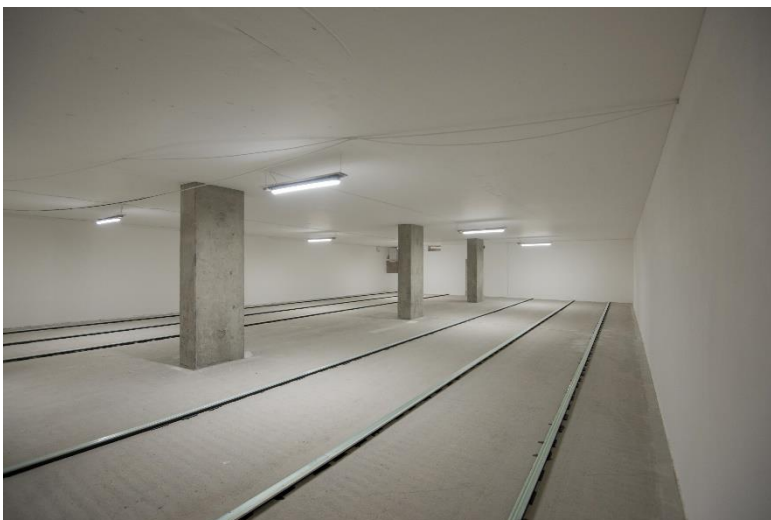
05 Die ersten Wände sind bereits gestrichen, Juni 2020, Foto: GNM/Florian Kutzer
