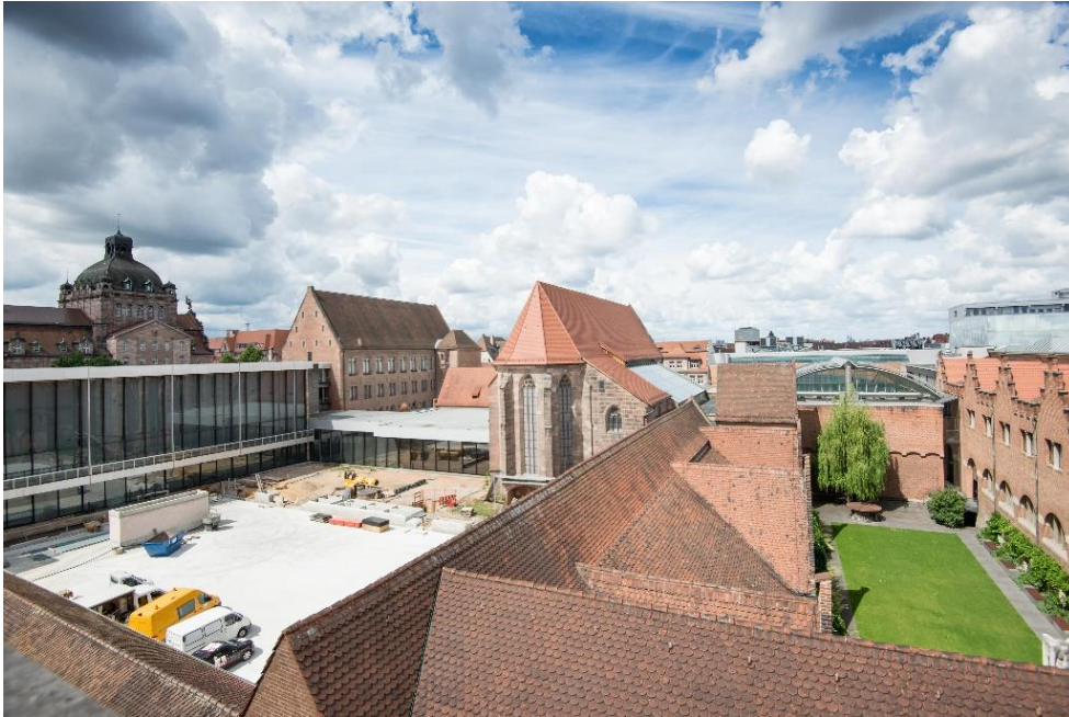
01_Blick von oben auf die Tiefdepot-Baustelle im Großen Klosterhof, Juni 2020 Foto: GNM/Florian Kutzer
